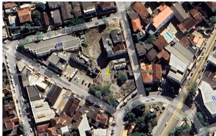
Área do empreendimento
