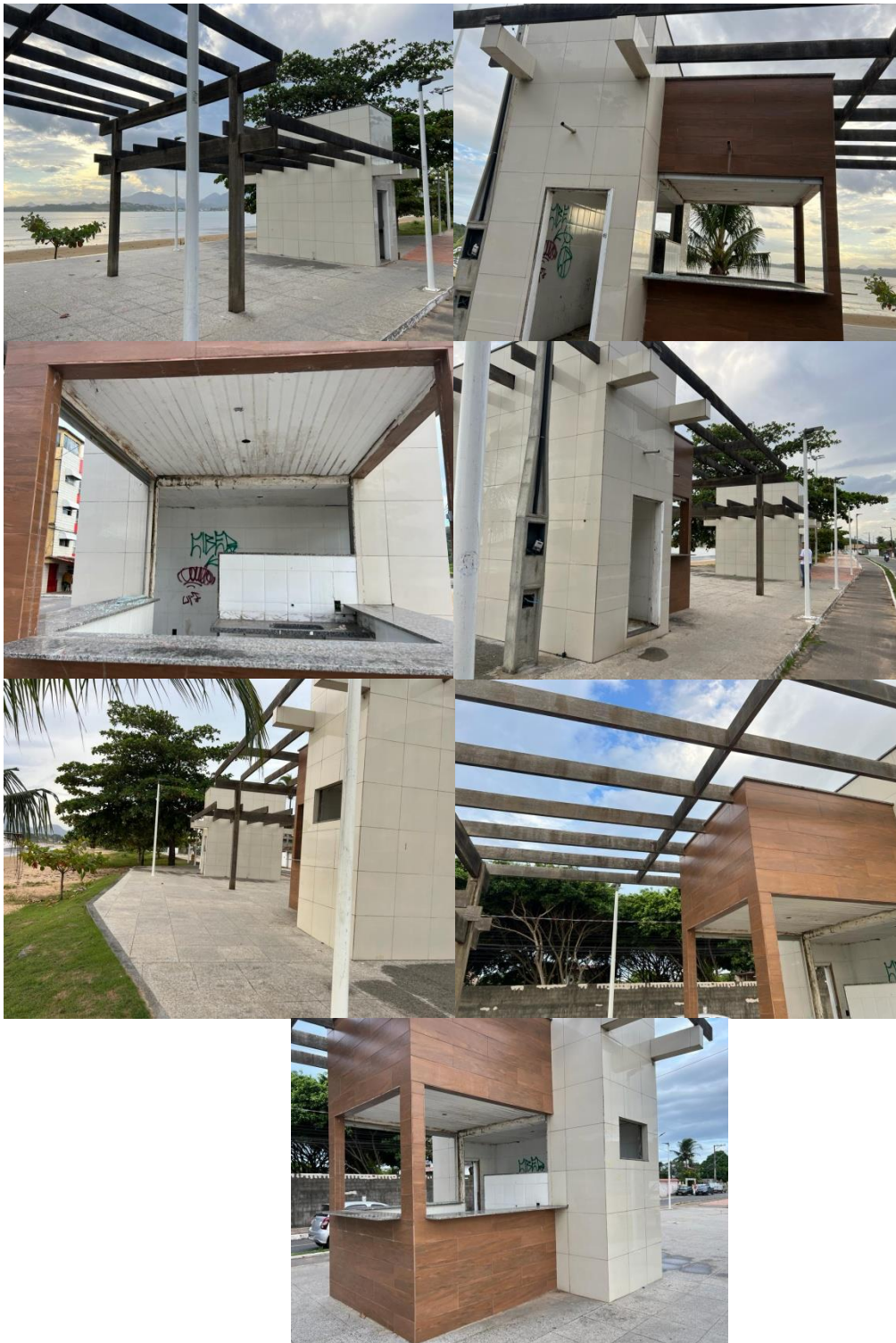
Foto Área Externa Quiosque – 2 Santa Monica
