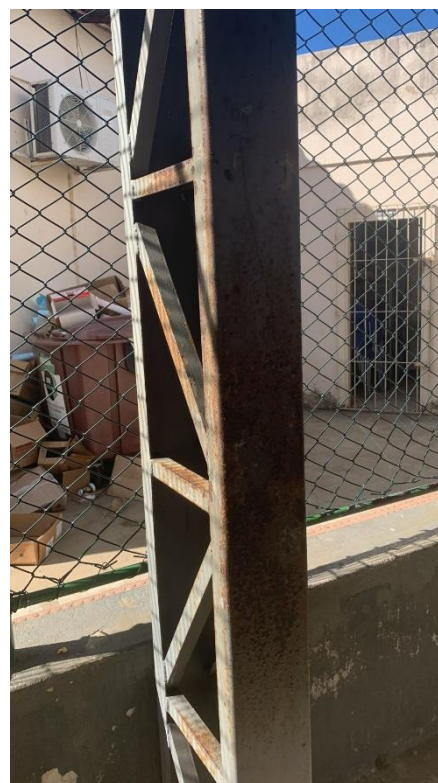
Oxidação uniforme presente nas peças
