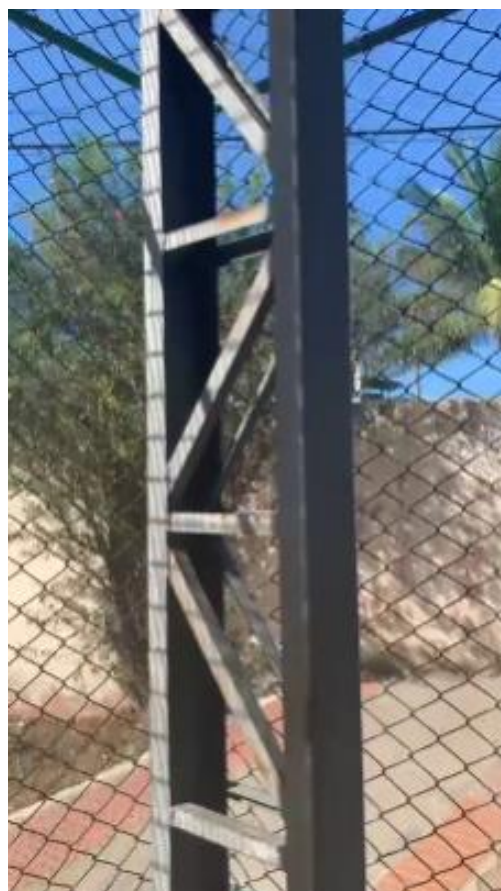
Oxidação uniforme presente nas peças
