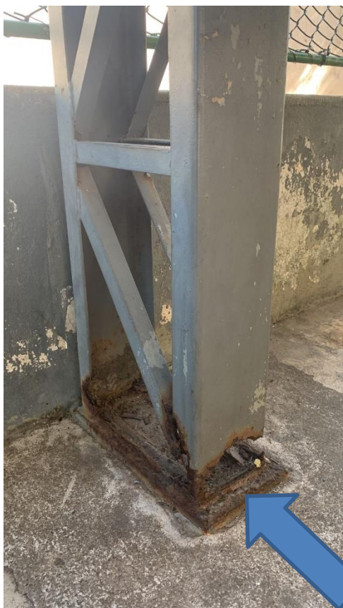
Oxidação uniforme presente nas peças
