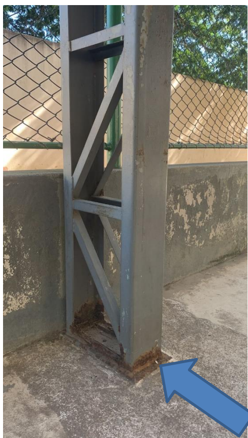
Oxidação uniforme presente nas peças
