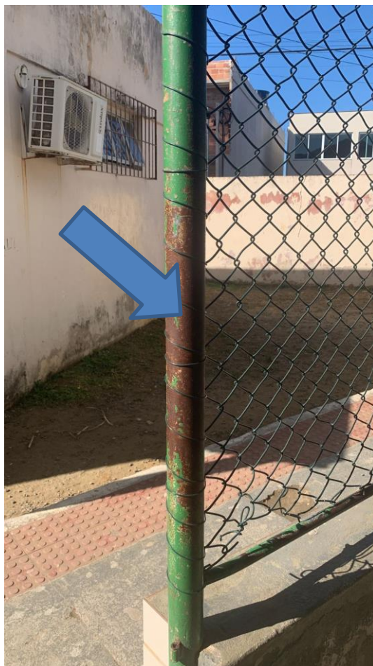
Oxidação uniforme presente nas peças de apoio do alambrado
