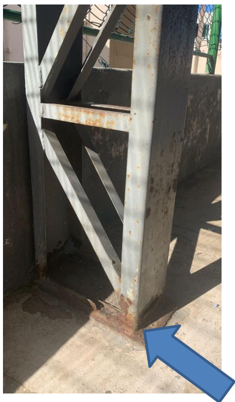
Oxidação uniforme presente nas peças
