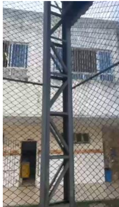
Oxidação uniforme presente nas peças
