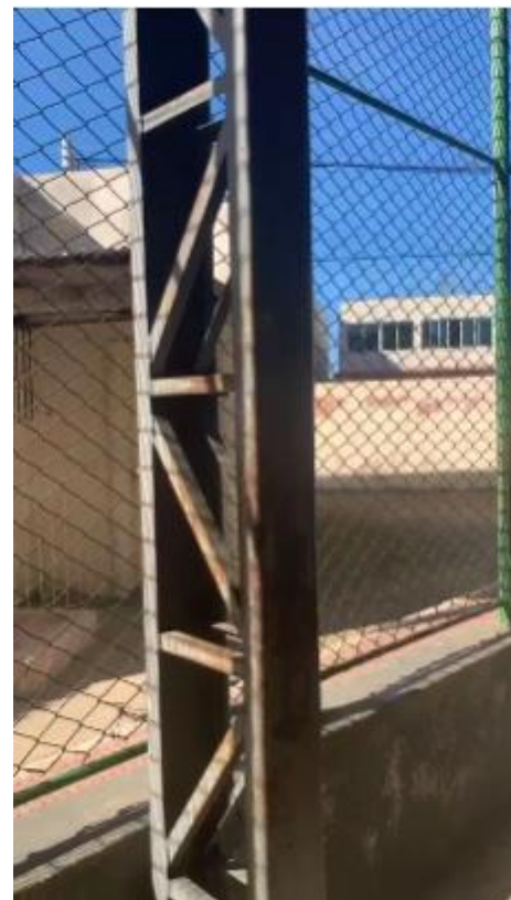
Oxidação uniforme presente nas peças
