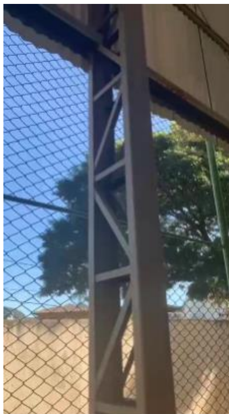
Oxidação uniforme presente nas peças
