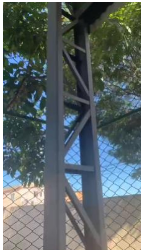
Oxidação uniforme presente nas peças
