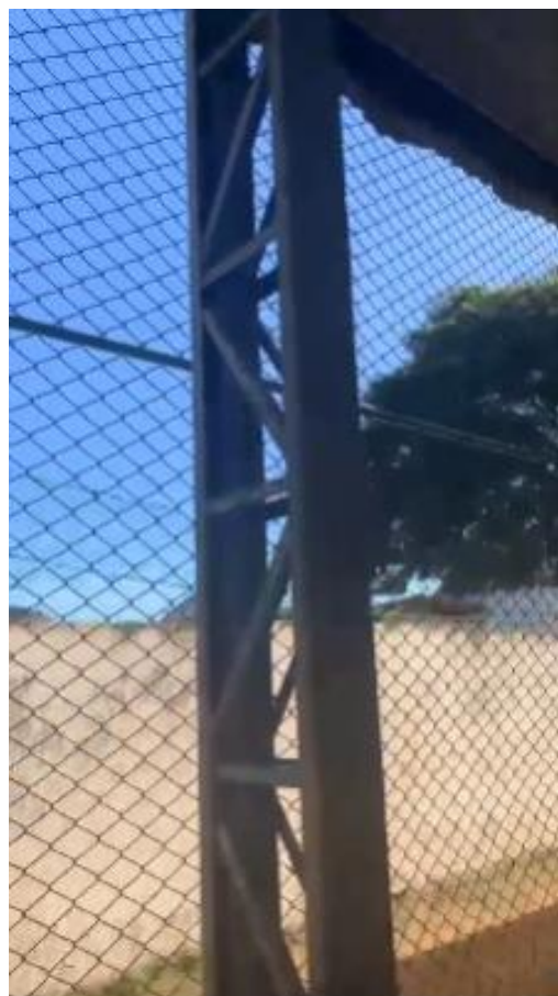
Oxidação uniforme presente nas peças
