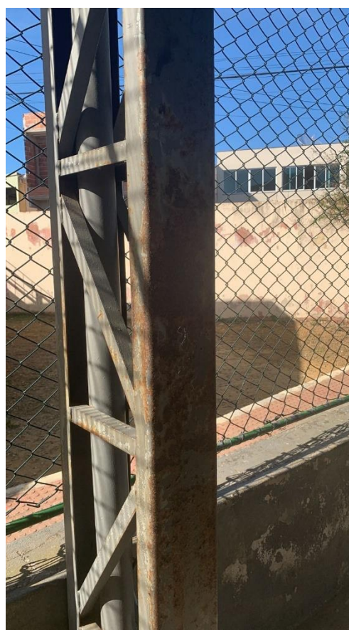
Oxidação uniforme presente nas peças
