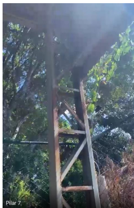
Oxidação uniforme presente nas peças
