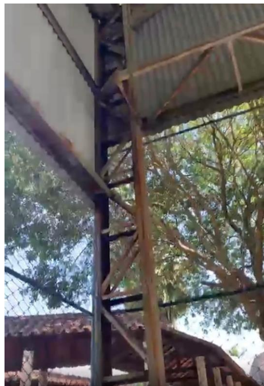
Oxidação uniforme presente nas peças
