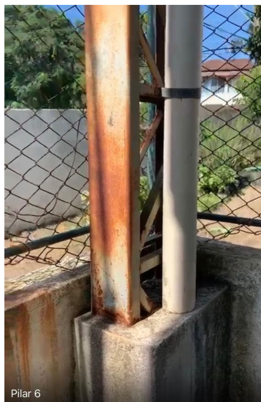
Oxidação uniforme presente nas peças
