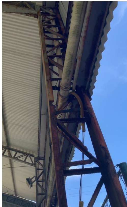
Oxidação uniforme presente nas peças
