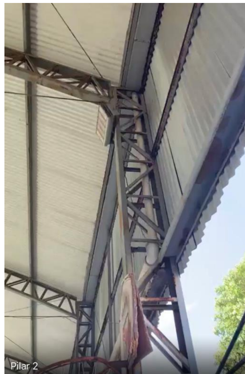
Oxidação uniforme presente nas peças
