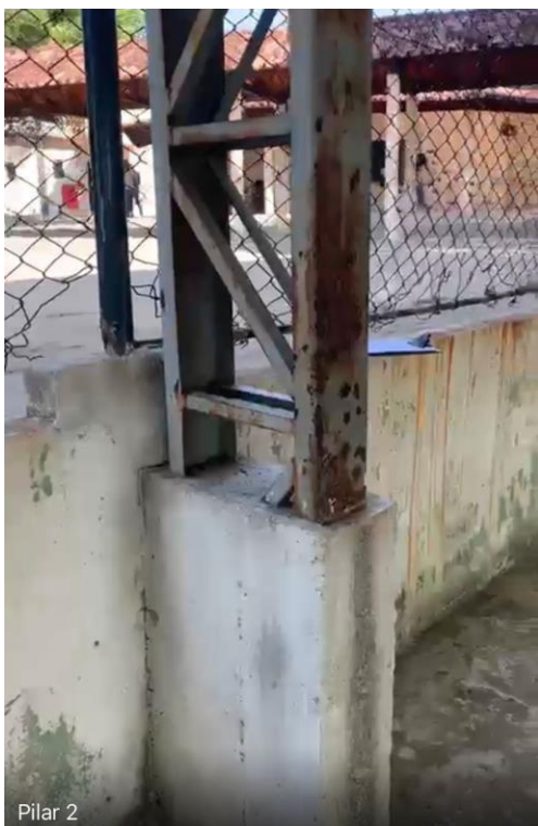
Base de concreto
