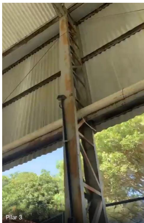
Oxidação uniforme presente nas peças
