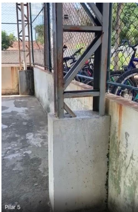
Base de concreto
