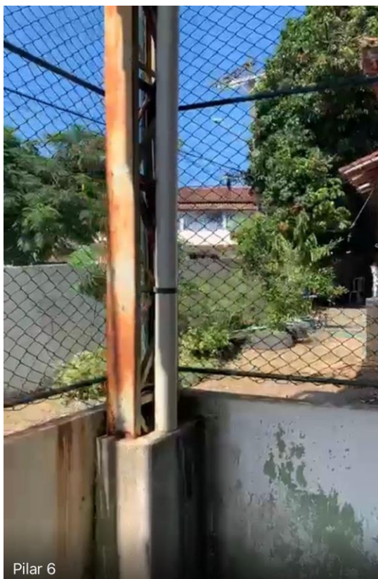
Base de concreto
