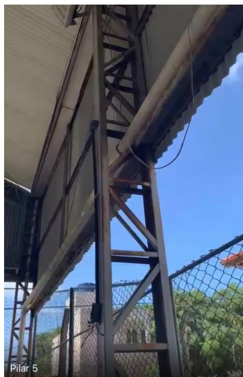
Oxidação uniforme presente nas peças
