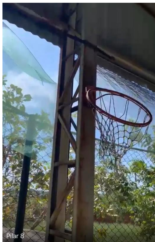
Oxidação uniforme presente nas peças
