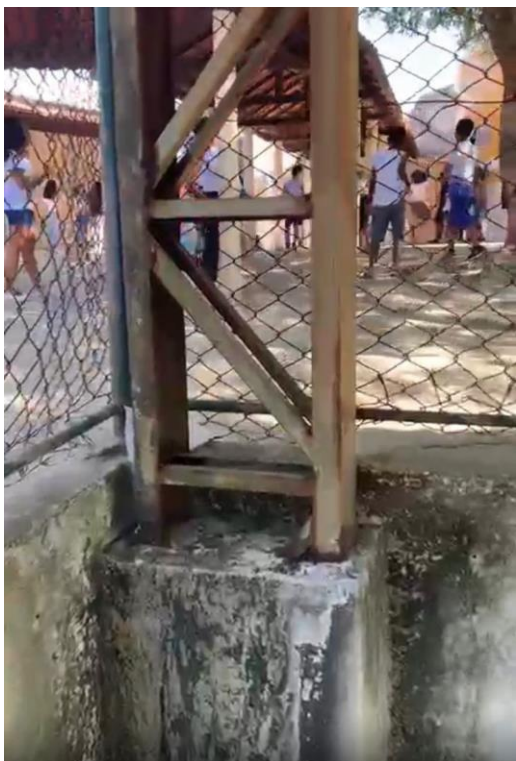
Oxidação uniforme presente nas peças
