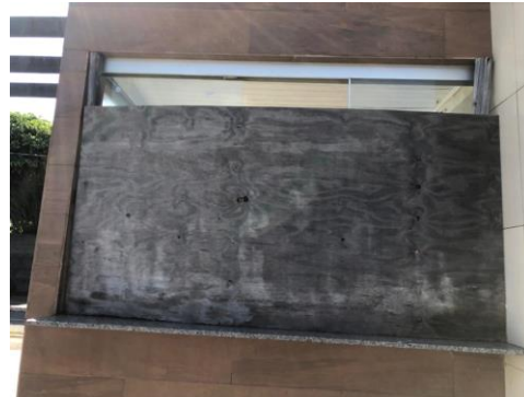
Foto Lateral: Vidro da janela de atendimento ao cliente quebrado. Coberto com tábuas de madeira.
