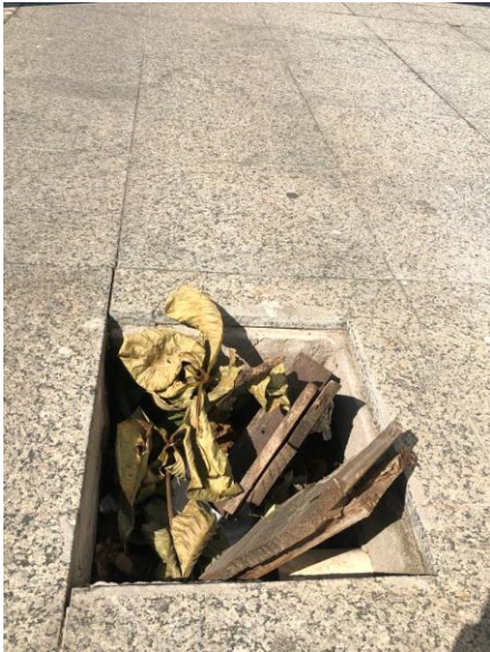
Fotos do chão/ calçada: Bueiros que dão acesso a ligamento de água ou energia expostos e sem tampas, implantando perigo.
