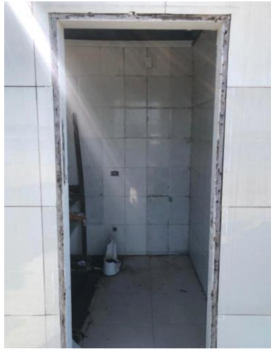
Fotos Banheiros: Um com porta de acesso danificadas e o segundo sem porta, ou qualquer proteção.
