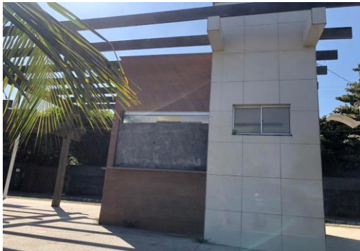
Foto Lateral: Vidro da janela de atendimento ao cliente quebrado. Coberto com tábuas de madeira.
