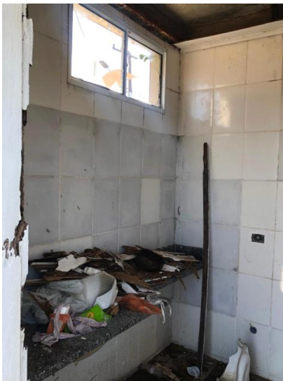
Fotos banheiro (área interna): Fotos da estrutura interna de um dos banheiros. Condições precárias. Faltando vaso, pia, torneira. Teto sem acabamento.
