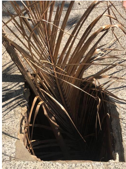
Fotos do chão/ calçada: Bueiros que dão acesso a ligamento de água ou energia expostos e sem tampas, implantando perigo.
