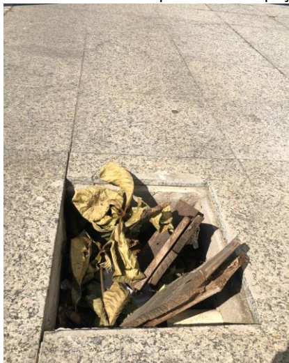
Fotos do chão/ calçadão: Bueiros que dão acesso a ligamento de água ou energia expostos e sem tampas, implantando perigo.
