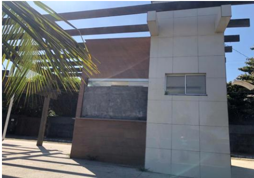
Foto Lateral: Vidro da janela de atendimento ao cliente quebrado. Coberto com tábua de madeira.
