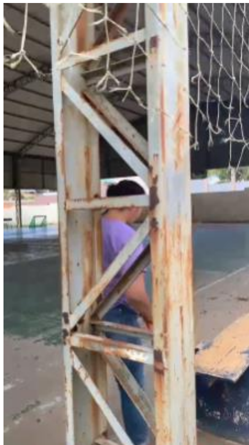
Oxidação uniforme presente nas peças
