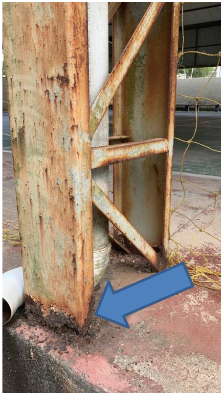
Oxidação uniforme presente nas peças
