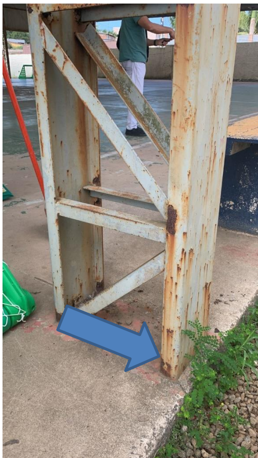
Oxidação uniforme presente nas peças
