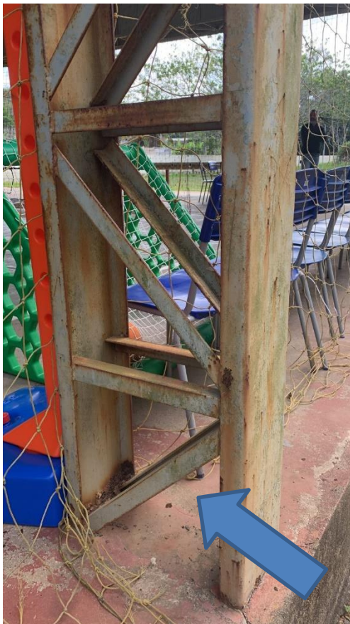
Oxidação uniforme presente nas peças
