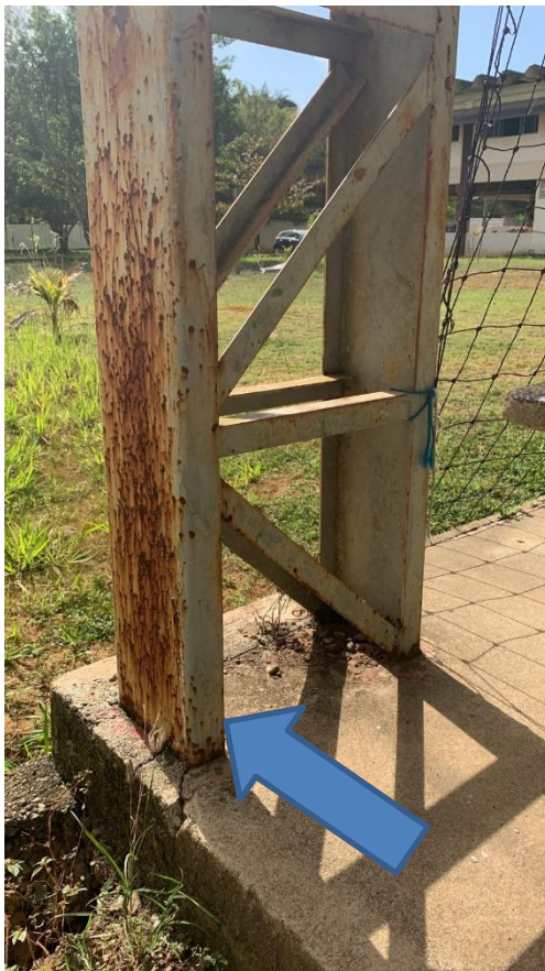
Oxidação uniforme presente nas peças
