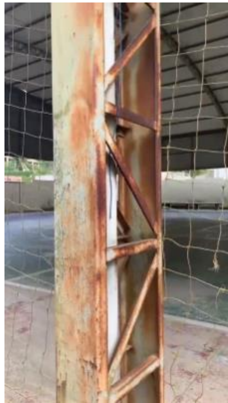
Oxidação uniforme presente nas peças
