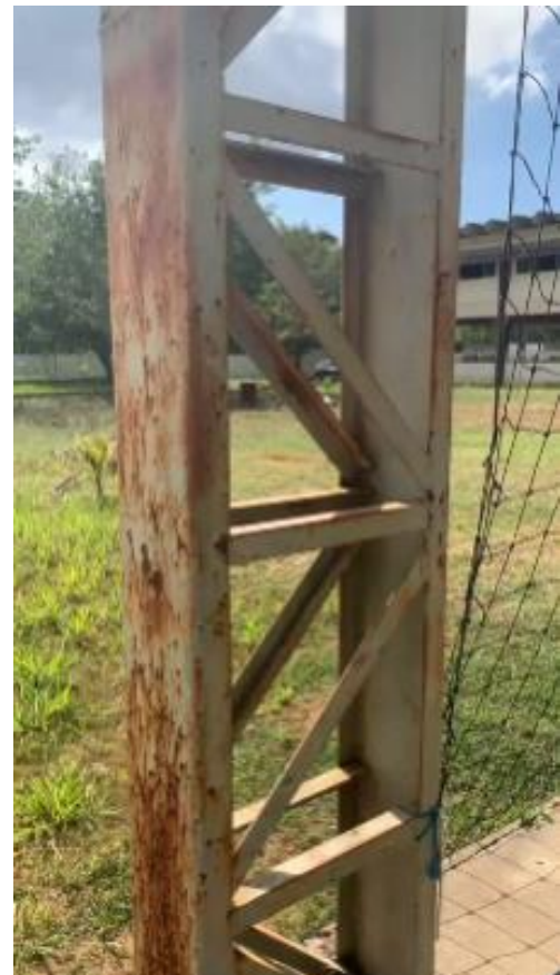
Oxidação uniforme presente nas peças
