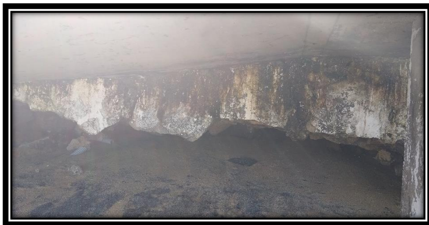
Reforço estrutural muro de contenção Orla Areia Preta
