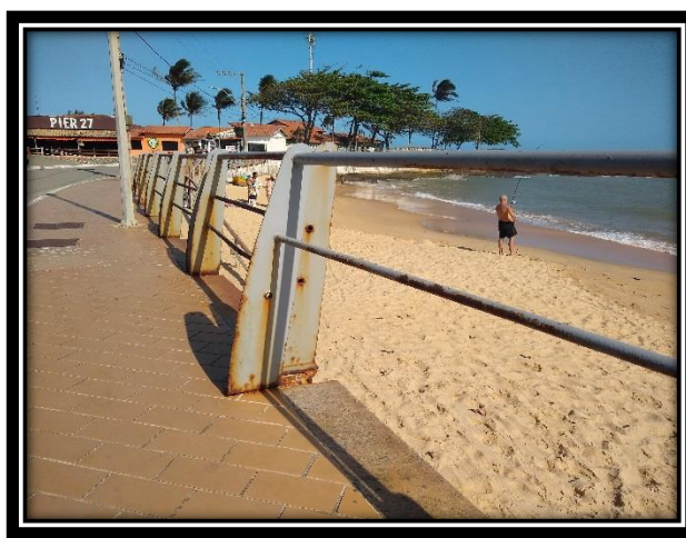
Reforma dos guarda-corpos – Praia Areia Preta
