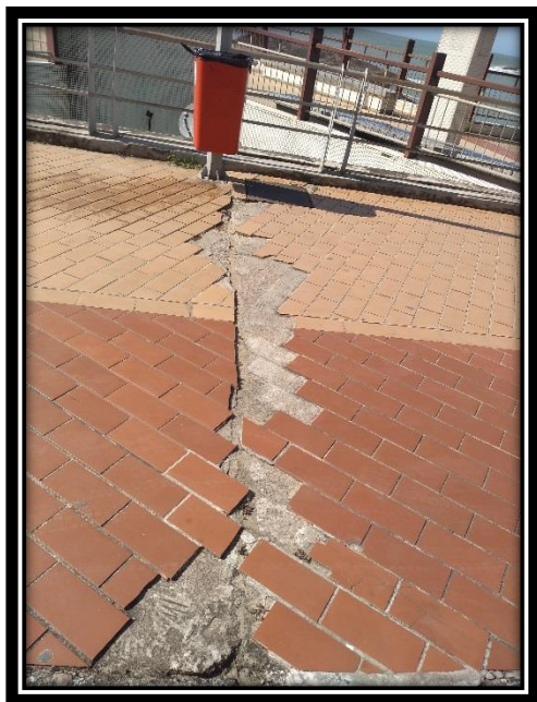
Pisos soltos e problemas nas juntas de dilatação
