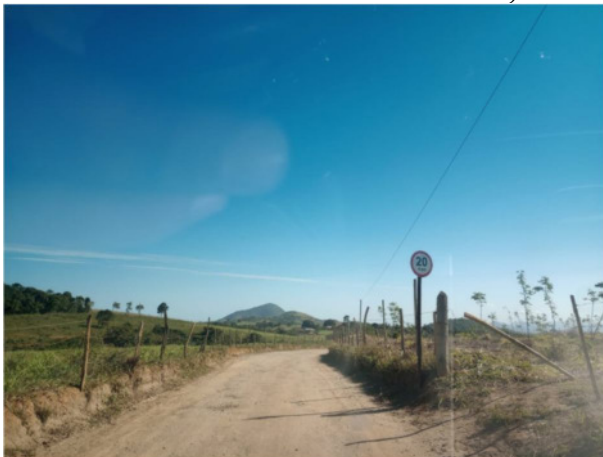
Vista das melhorias executadas nas estradas municipais mediante aplicação de solo brita, abertura de trechos estreitos, sinalização vertical e manutenção corretiva.
