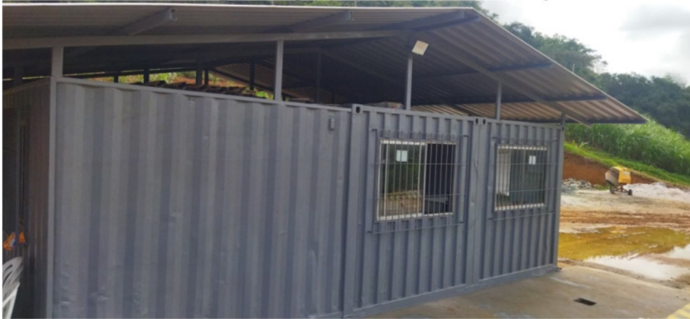
Unidade 01 que abriga o refeitório e o almoxarifado.
