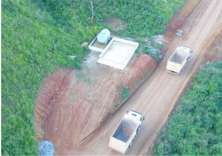
Vista panorâmica da unidade 03 após a conclusão da obra de instalação.
