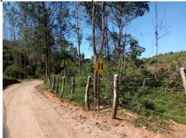
Vista das melhorias executadas nas estradas municipais mediante aplicação de solo brita, abertura de trechos estreitos, sinalização vertical e manutenção corretiva.
