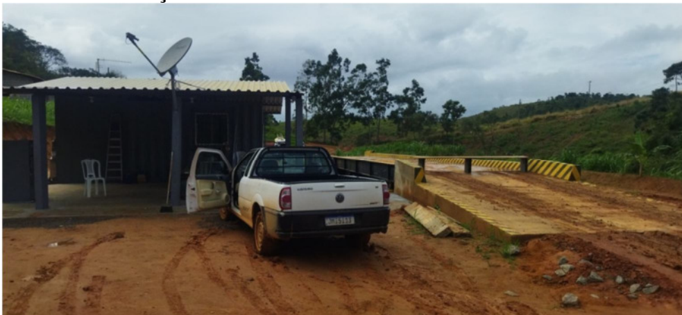
Balança rodoviária instalada ao lado da unidade 01.
