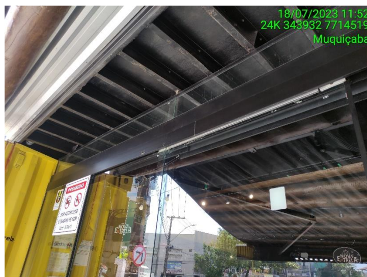
Figura 05: Detalhe dos vãos formados entre a esquadria e o teto.
