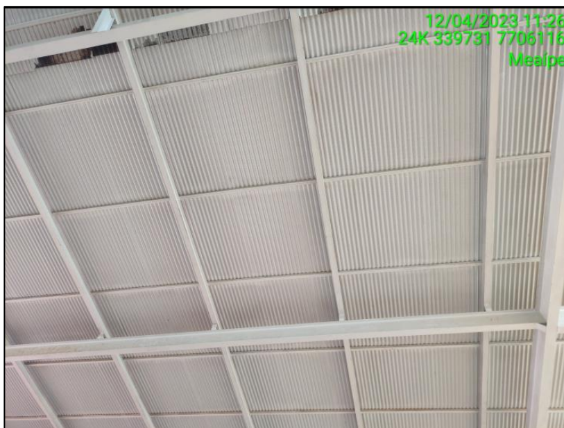
Figura 20 – Forro metálico perfurado com lã de rocha.
