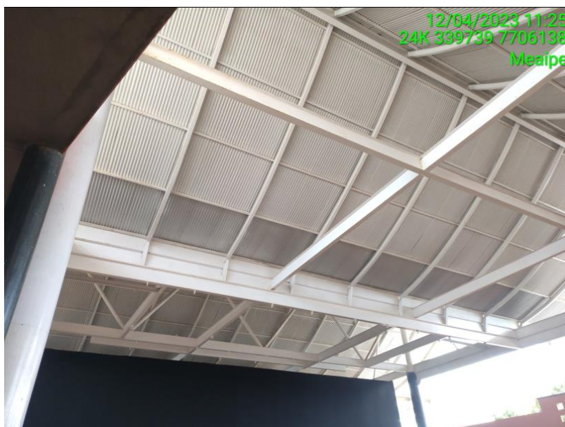
Figura 21 – Forro metálico perfurado com lã de rocha acompanhando o teto mais alto.
