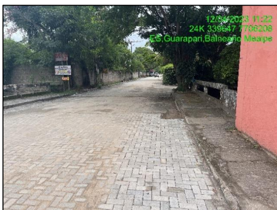
Figura 52: Calçada fora de padrão e interrompida por árvore.
