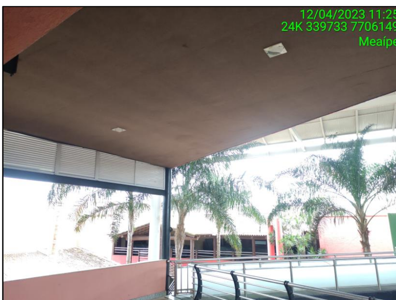
Figura 13 – Camarote 02 tem detalhe do forro com revestimento têxtil.
