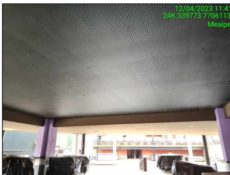
Figura 16 – Asteroide – destaque forro micro perfurado e com lã de vidro.
