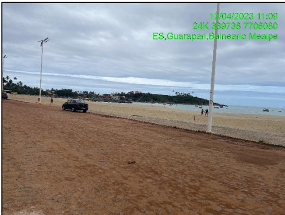
Figura 47: Calçada fora de padrão do lado da praia.
