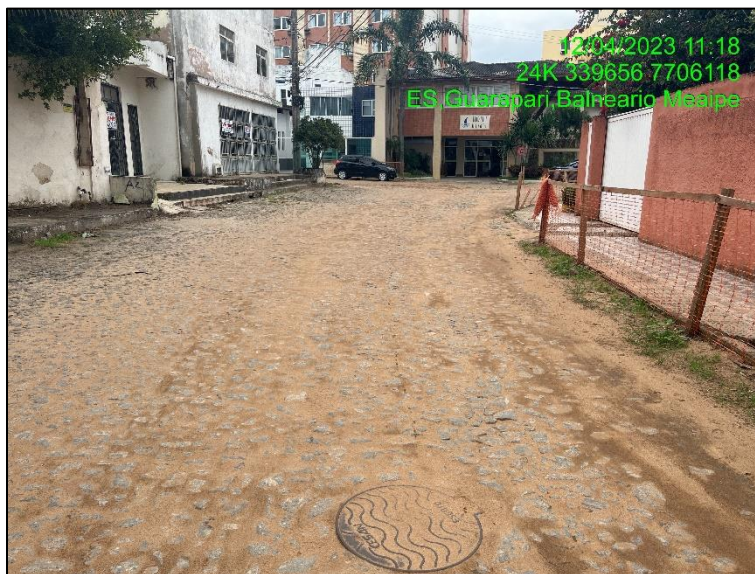
Figura 51: Rua Claudionor Vieira de Matos com destaque para a tampa do poço de visita da rede de esgoto.
