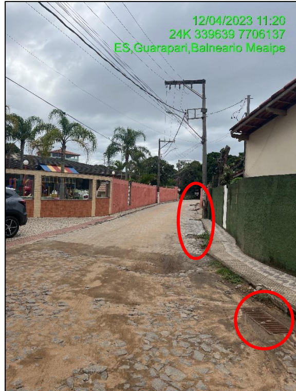
Figura 53: Dispositivos de drenagem na rua Izaltino Alves.
