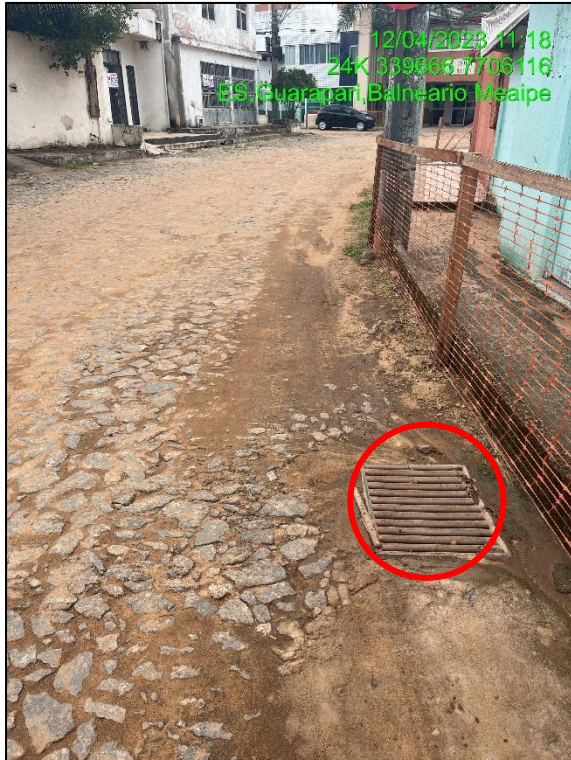
Figura 52: Dispositivo de drenagem na rua Claudionor Vieira de Matos.
