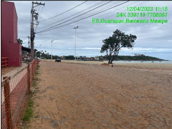
Figura 45: Trecho de calçada regular na frente do empreendimento.
