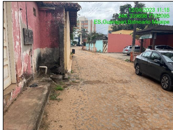
Figura 42: Calçada descontinuada na frente do empreendimento (outro lado da rua).
