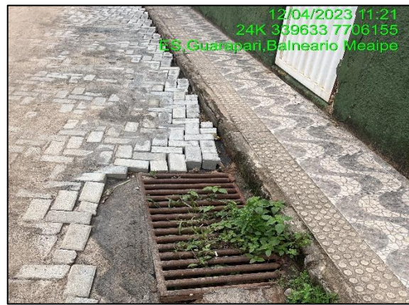
Figura 55: Detalhe do dispositivo de drenagem da rua Izaltino Alves.
