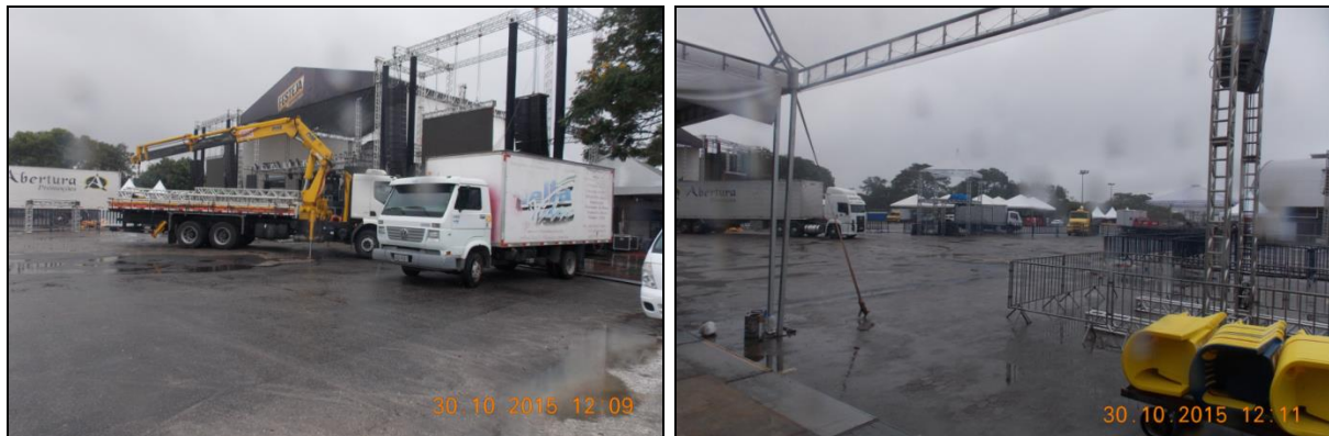
Figura 25 a. b.: Operações de carga e descarga - 30/10/2015 – Montagem e Abastecimento. Fonte: EIV Pavilhão de Carapina - Atena (2016).
