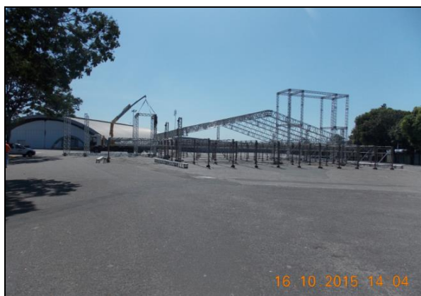
Figura 19 a. b.: Operações de carga e descarga - 16/10/205 - Uso de Caminhão Munck. Fonte: EIV Pavilhão de Carapina - Atena (2016).
