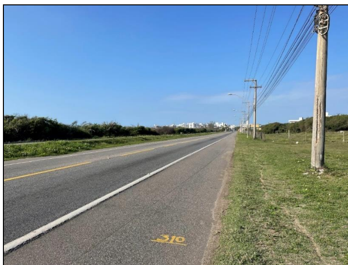
Figura 49: Rod. Paulo Borges, trecho sem calçada pavimentada
