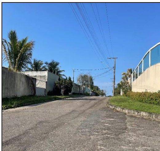
Figura 45: calçada sem pavimentação
