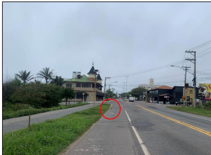
Figura 52: Foto da rodovia, sentido sul, com marcação de bueiro.
