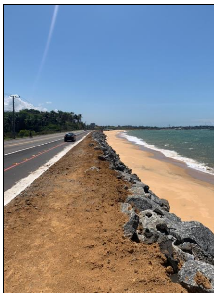
Figura 55: Vista da região costeira de Meaípe com a contenção da erosão.
