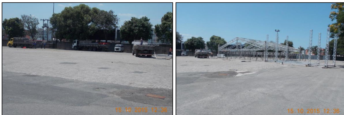
Figura 18 a. b.: Operações de carga e descarga - 15/10/2015 - Início da montagem. Fonte: EIV Pavilhão de Carapina - Atena (2016).
