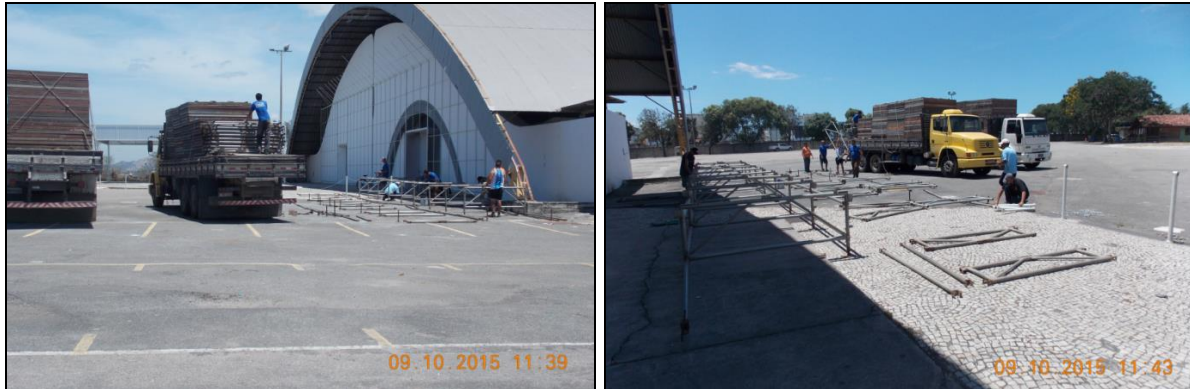
Figura 16 a. b.: Operações de carga e descarga - 09/10/2015 - Início da montagem. Fonte: EIV Pavilhão de Carapina - Atena (2016).
