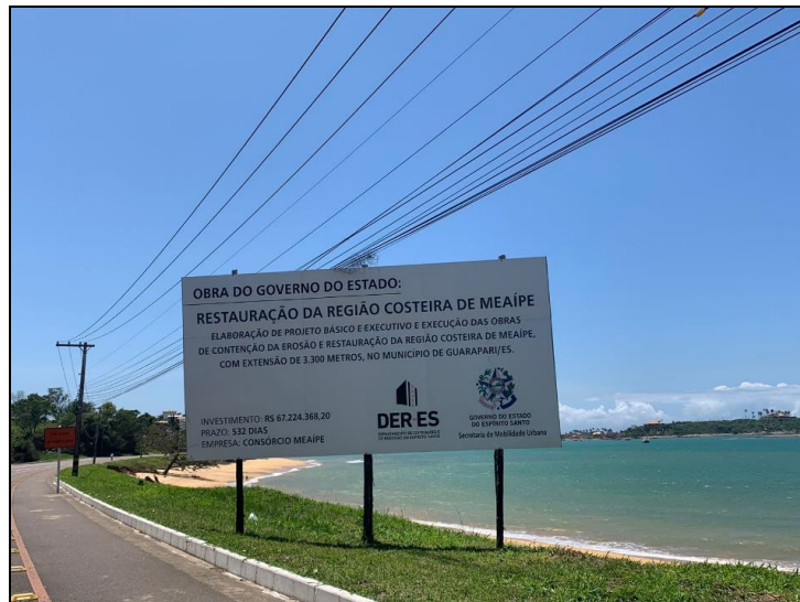
Figura 56: Vista da placa informativa da obra de contenção da erosão e restauração da região costeira de Meaípe.
