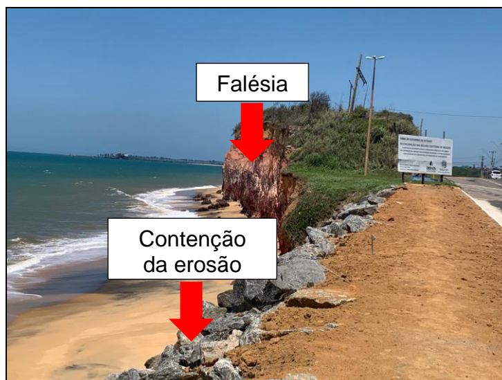
Figura 57: Litoral de Meaípe, ao fundo a formação de falésias e parte da obra de contenção da erosão.
