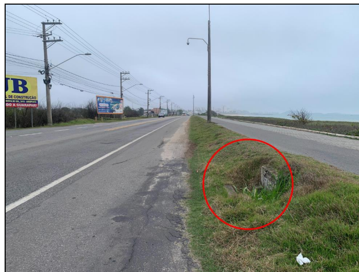
Figura 53: Foto da rodovia, sentido norte, com marcação de boca de lobo.
