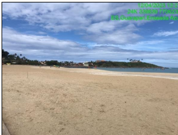
Figura 59: Praia de Meaípe (após conclusão da obra), Guarapari/ES.
