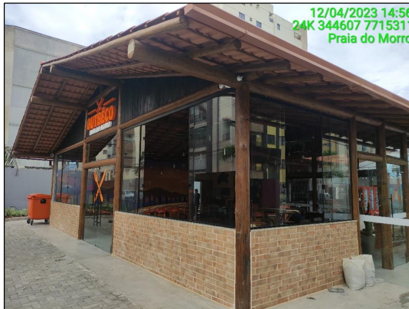
Figura 02: Fechamento em vidro do salão de refeições.
