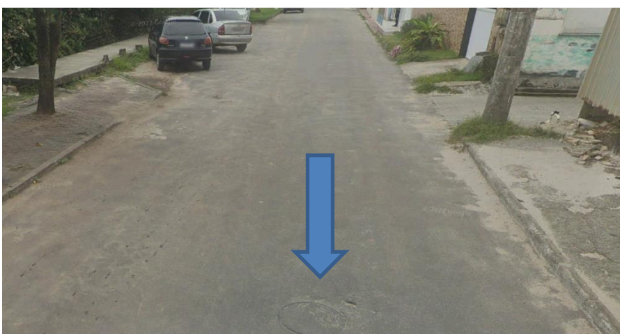
Figura 54 - Registro de Lançamento de esgoto na Rua Lúcio Rocha de Almeida Fonte: Google Earth em 28/09/2022
