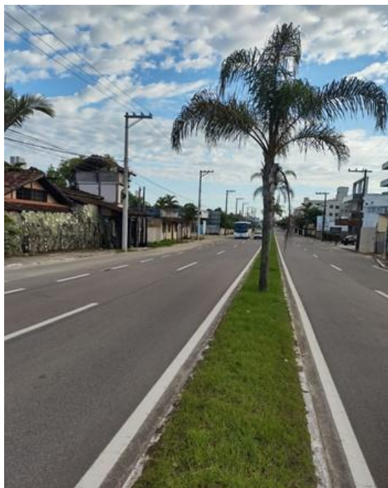
Figura 26: Avenida Meaípe - sentido Sul Fonte: Autor - Dez/2021
