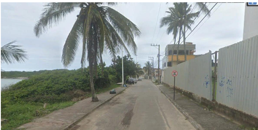
Figura 46 – Inexistência de calçada cidadã. Fonte: Google Earth.
