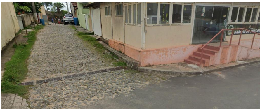
Figura 52 - Registro de ponto de Drenagem na Servidão I Fonte: Google Earth em 28/09/2022
