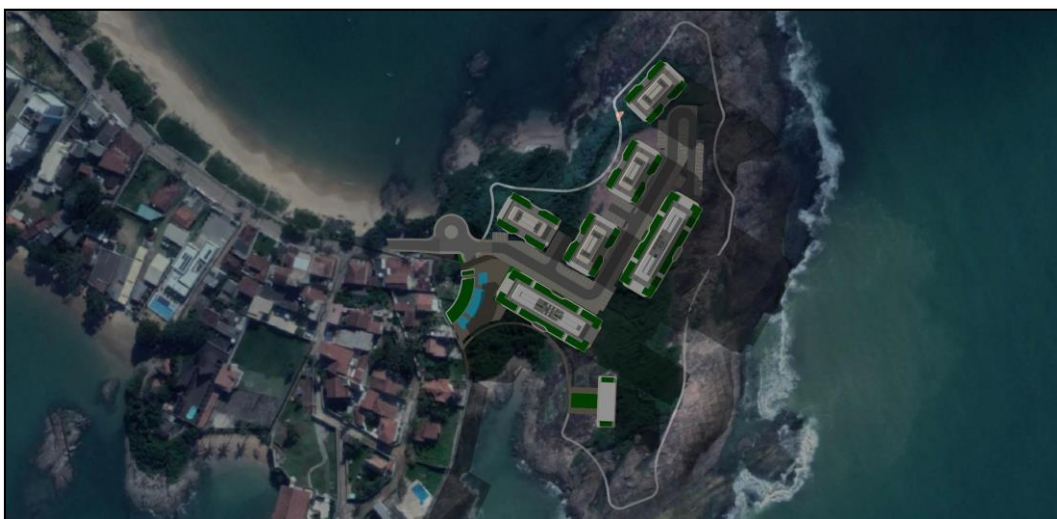
Figura 67 - Resultado do estudo de sombreamento para o dia 21 de junho (solstício de inverno - inclinação máxima para longe do sol) às 16:00h Fonte: ARKTETO
