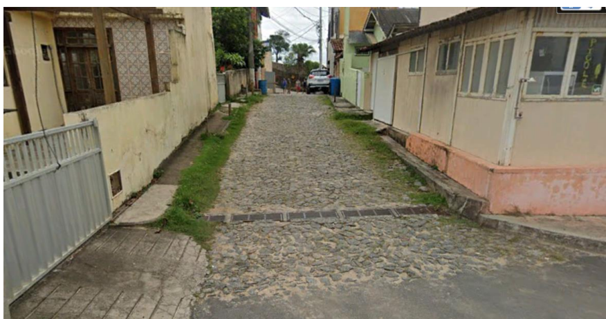
Figura 48 – Inexistência de calçada cidadã. Fonte: Google Earth.
