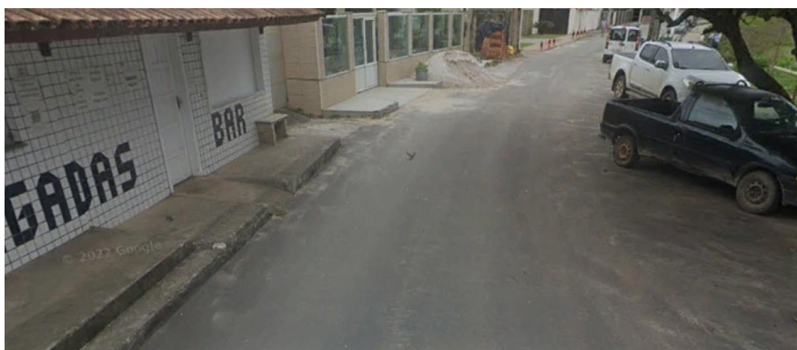
Figura 49 – Inexistência de calçada cidadã. Fonte: Google Earth.
