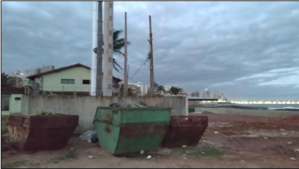
Figura 3: Área futura do armazenamento temporário. Fonte: Arquivo próprio.
