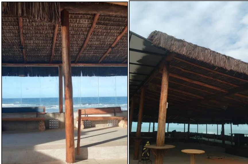
Figura 05: Fechamento em vidro, área interna de fundo.
