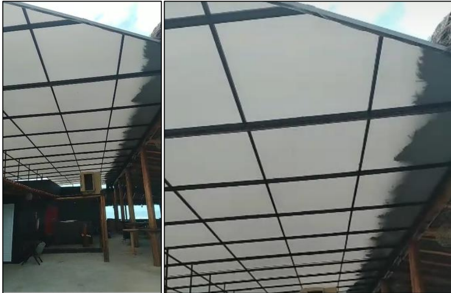
Figura 06: Cobertura em lona da área lateral esquerda.
